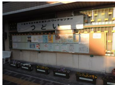
1階外壁の屋外掲示板
